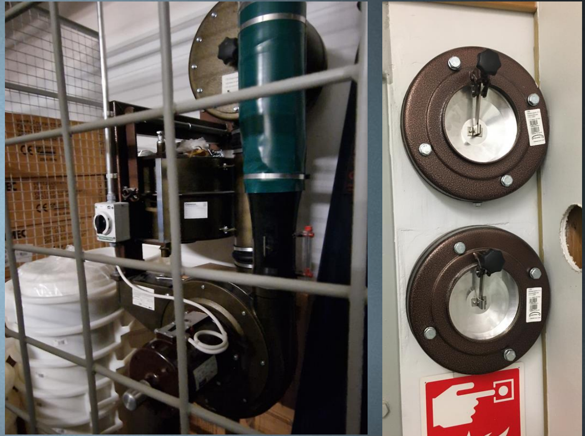
Pav. ESL-150 saugomas nuo pašalinių ir viršslėgio vožtuvai
