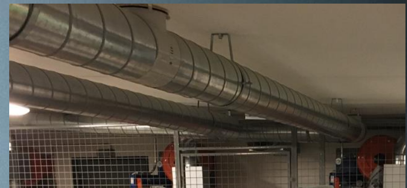
Pav. standus šviestuvų tvirtinimas Pav. standus ortakijų tvirtinimas
