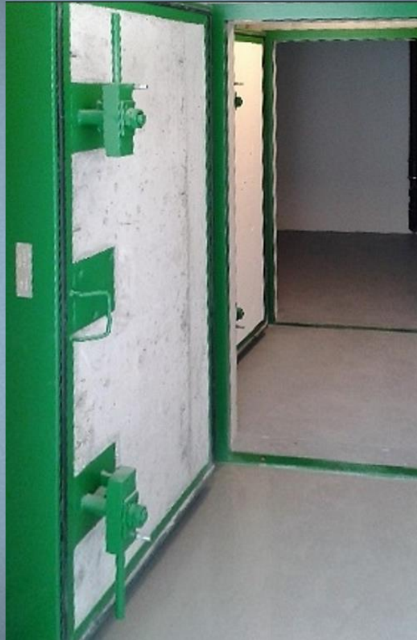
Pav. betoninės SPKAS durys
