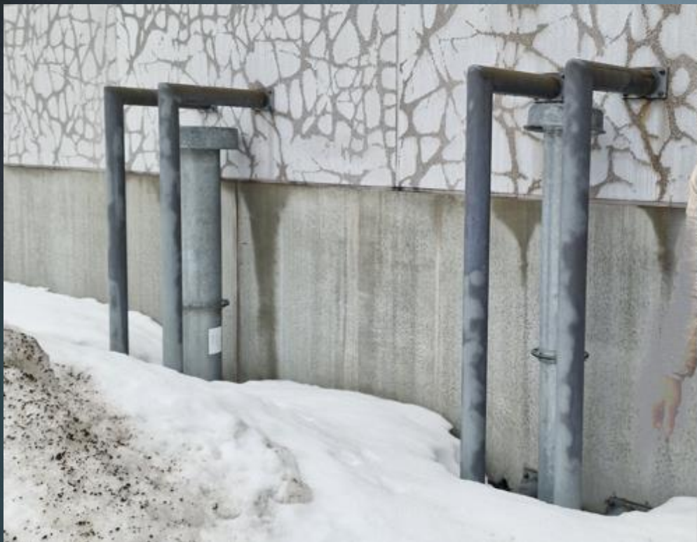
Pav. oro paėmimo angos išvestos į lauką galimos griūtis zonoje ir apsaugotos nuo pažeidimo
