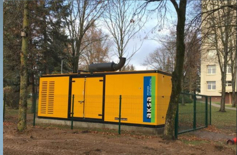
Pav. vieta generatoriui parinkta toliau nuo pastatų griūties zonos, bet nėra apsaugos nuo kinetinio poveikio
