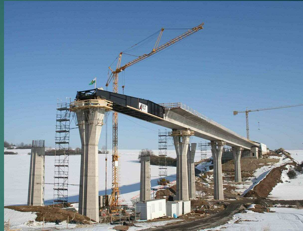
Pav. Inžinerinis statinys - estakada
