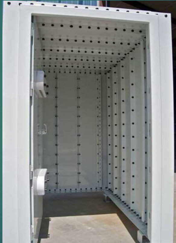
Pav. Pertvarų stiprinimui naudojami plieniniai skydai
