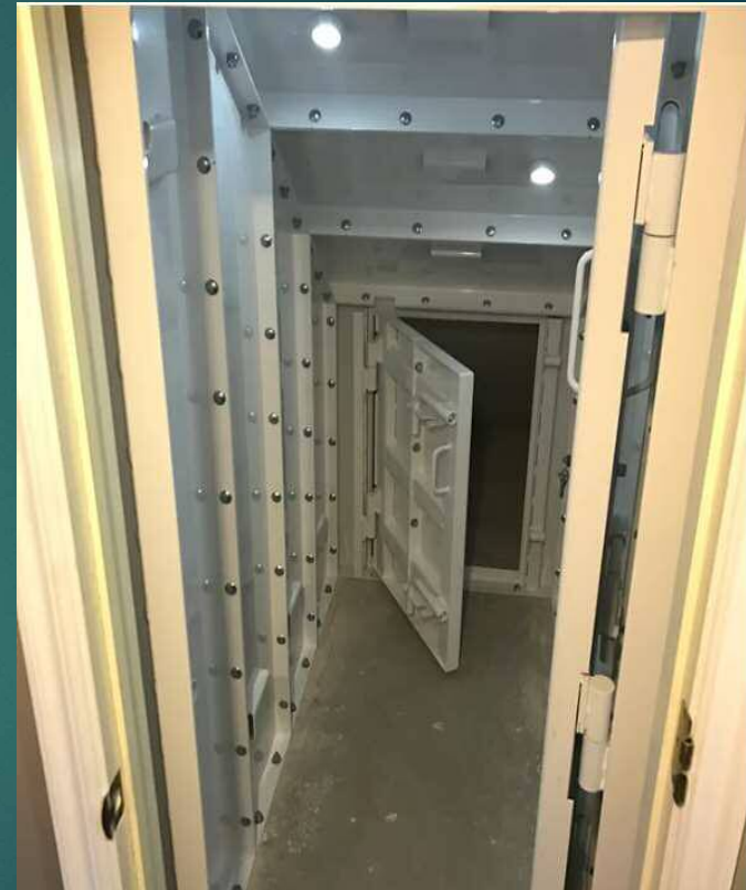
Pav. Pertvarų stiprinimui naudojami plieniniai skydai
