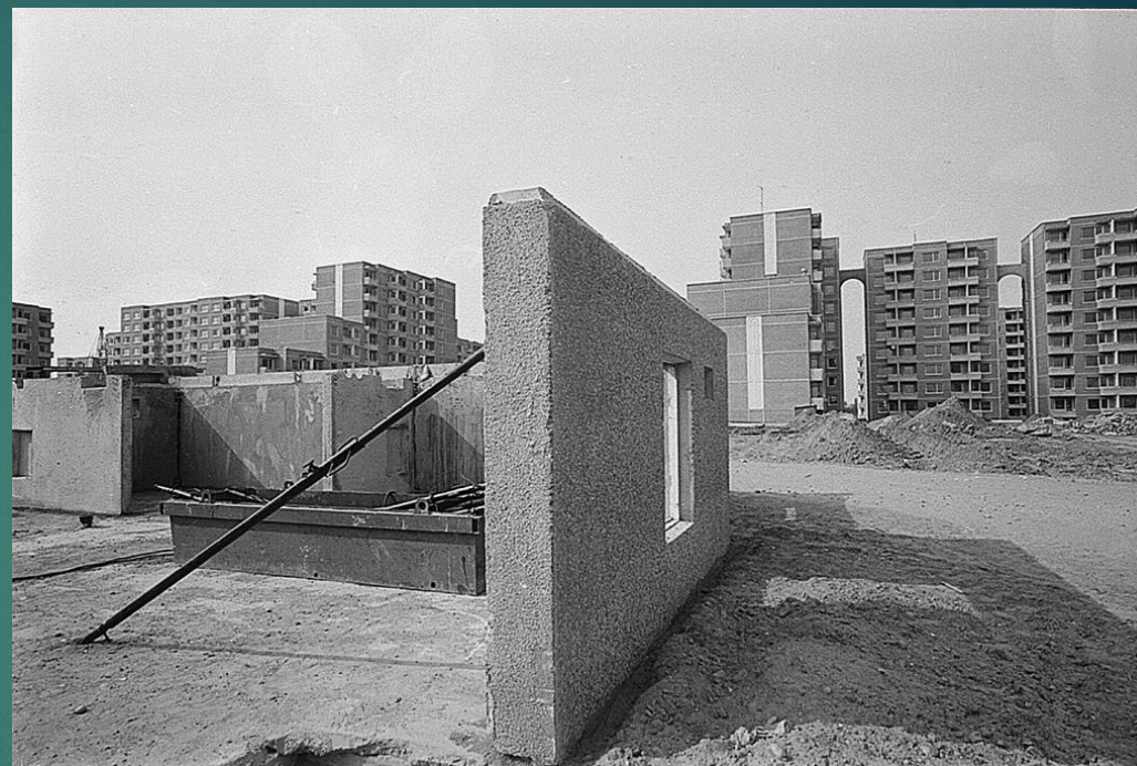
Pav. Stambiaplokščio namo statyba
