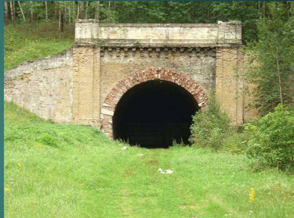
Pav. Požeminis inžinerinis statinys (tunelis)
